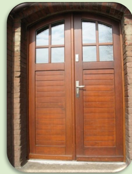
Wymiana czterech par drzwi wejściowych oraz nasadzenia drzew 43 747 zł (Powiatowy Fundusz Ochrony Środowiska)
