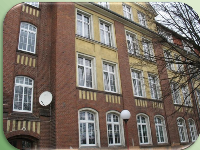
Wymiana okien w budynkach szkolnych 131 655 zł
