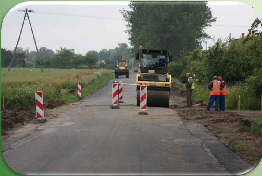
Droga Bierzglinek-Gozdowo w trakcie przebudowy...
