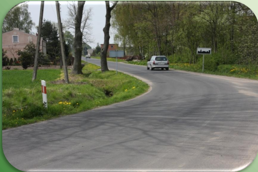
Przebudowa odcinka drogi powiatowej w Nowej Wsi Królewskiej - 247 116 zł
