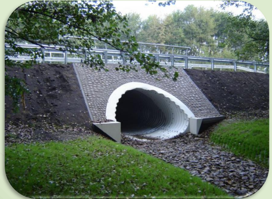
Przebudowa mostu w Zapowiedni - 339 957 zł
