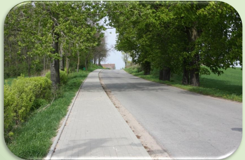
Remont odcinka chodnika w miejscowości Targowa Górka w ciągu drogi powiatowej nr 2933 Nekla – Mystki - 56 477 zł
