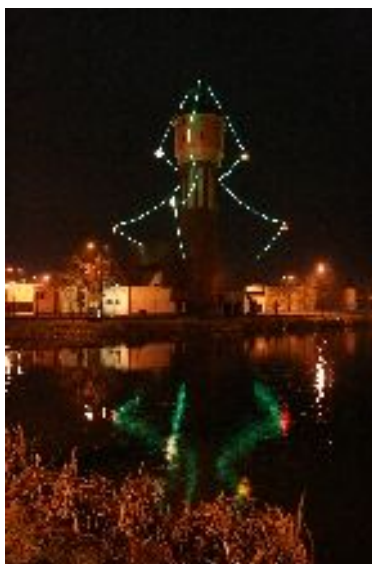
Stacja Uzdatniania Wody - Września
