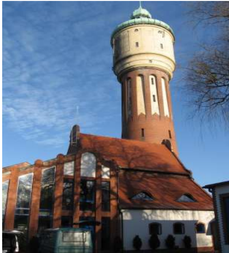
Stacja Uzdatniania Wody - Września
