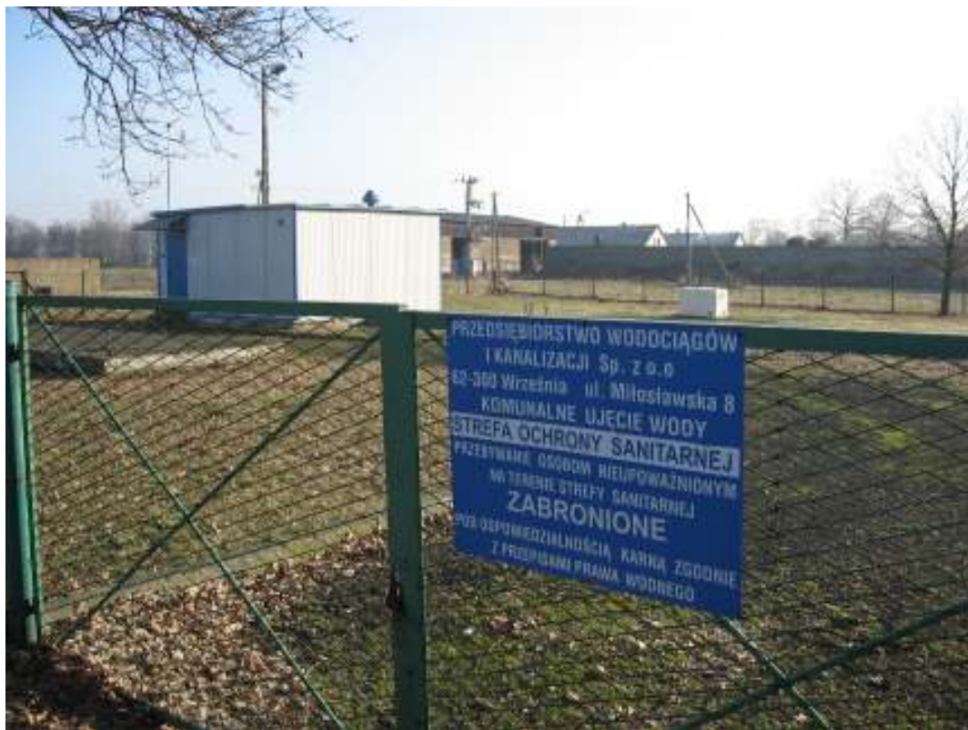
Stacja Uzdatniania Wody - Grzybowo
